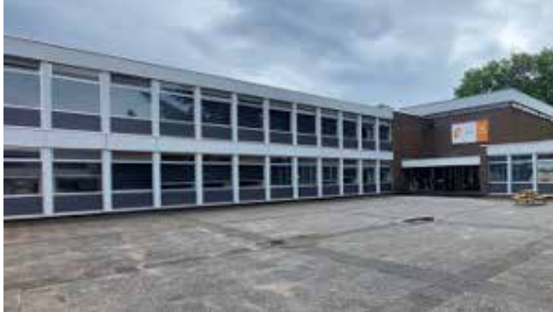
Tijdelijke huisvesting op een bedrijventerrein
