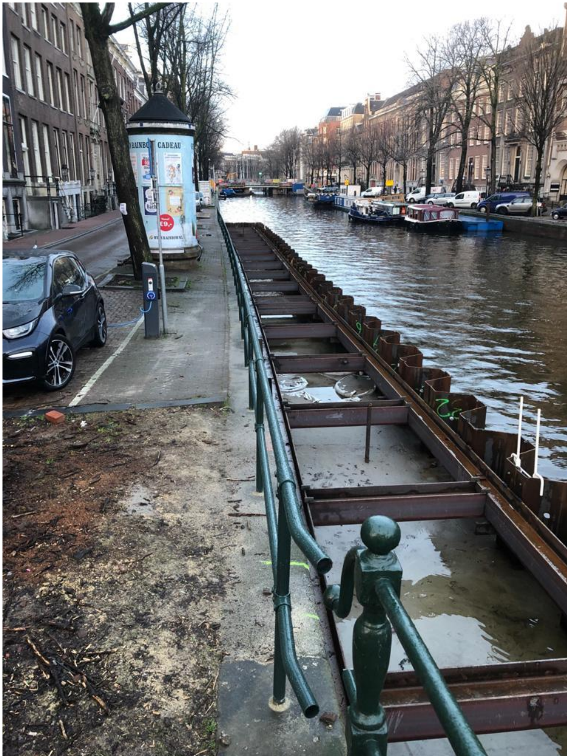
Foto 2, overzicht van de leuning met daarbij de overgang naar een brugleuning.
