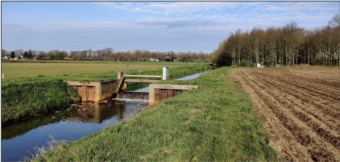
Beeld van de stuw. Het gemaal is op de achtergrond zichtbaar.
