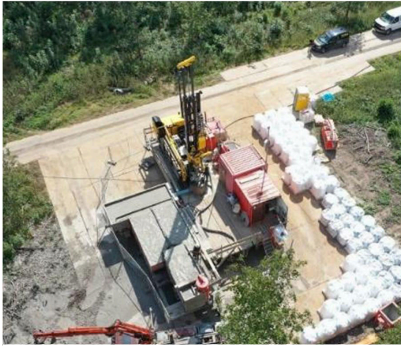
Figuur 2.1 Voorbeeld opstelling boor en indeling werkterrein
