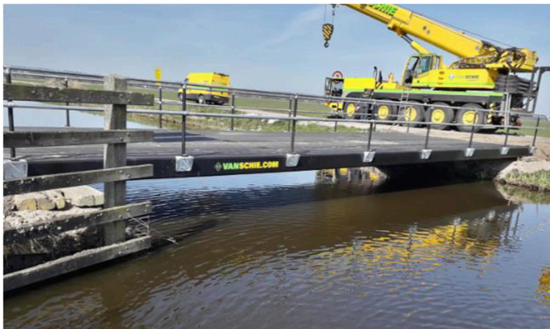
Figuur 5.1 Voorbeeld tijdelijke brug
