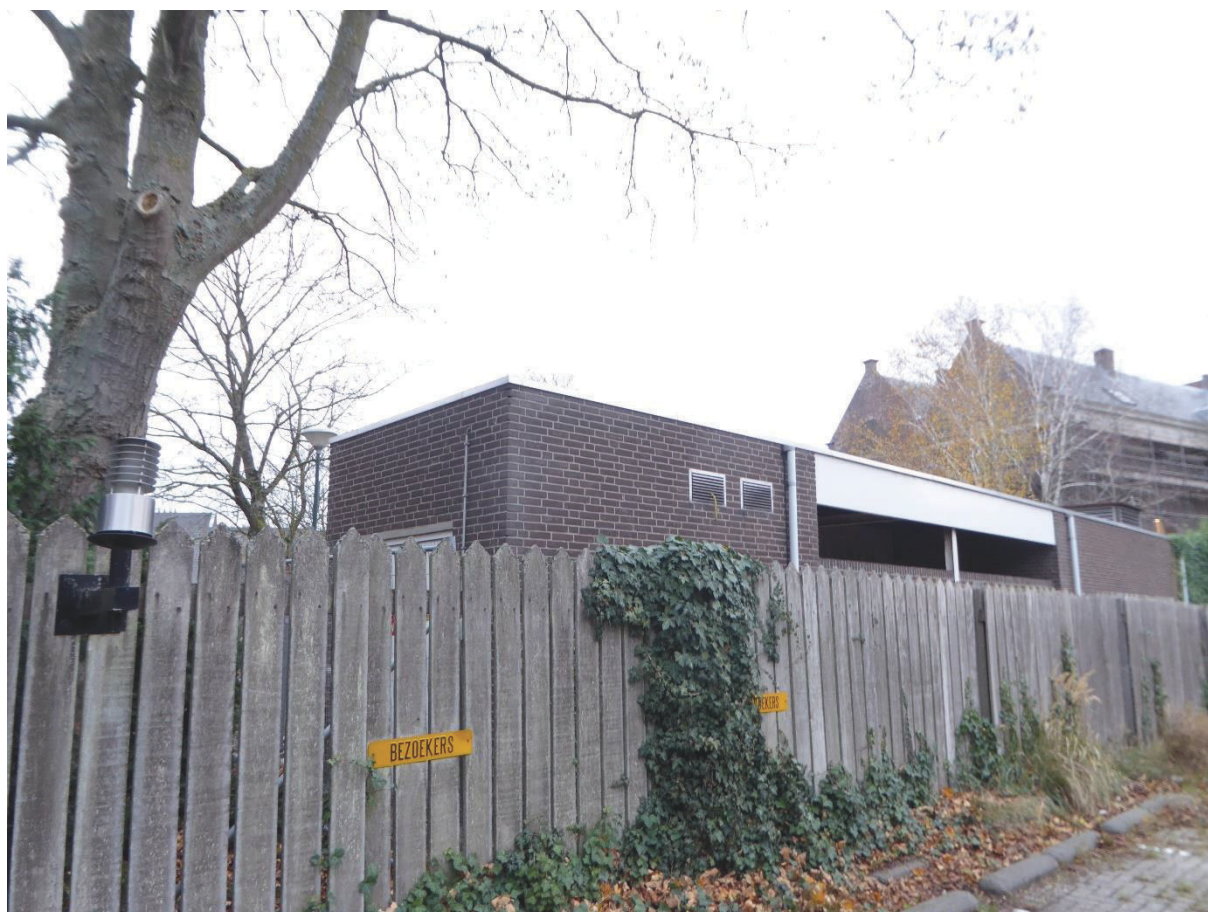
Figuur 5. Transformatorgebouw op het terrein van de voormalige Seeligkazerne.
