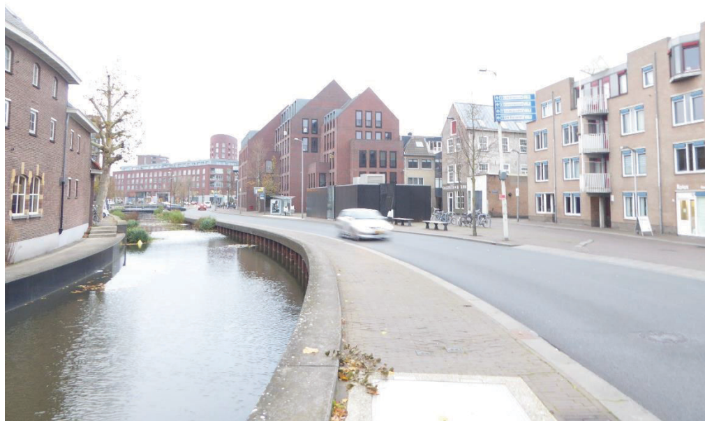
Figuur 12. Deelgebied 1. Hier is de Nieuwe Mark al aanwezig. Het waterpeil wordt hier kunstmatig hoog gehouden.
