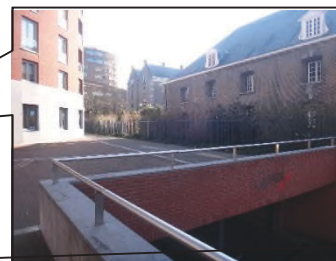
Ondergrondse parkeergarages Baronie en Centrum
