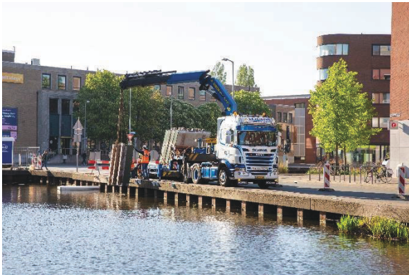
Bestaande situatie de Nieuwe Mark (damwanden)
