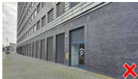
Technische voorzieningen in de plint geven een gesloten gevelbeeld (Chasséveld)
