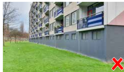
Plint met bergingen op de begane grond geeft een gesloten gevelbeeld vanuit de straat (Doornboslaan, Hoge Vucht)
