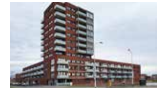
Maasdijk (ca. 40 m)
