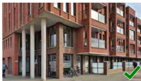
Entree met verticale geleding en verspringingen in de gevel (De Zon, Marksingel)
