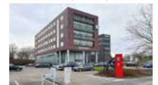
Hoogbouw langs A16, Lage Mosten (ca. 25 m)
