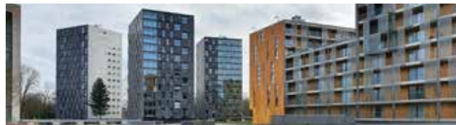
Hoogbouwmilieu met eigenstandige signatuur, Chassépark (ca. 30 - 40 m)
