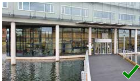
Open plint met hoge verdiepingshoogte en veel glas (Rat Verleghstraat)
