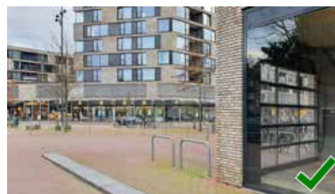
Entree parkeergarage binnen de rooilijn van gebouw en transparant vormgegeven (Doctor Struyckenplein)
