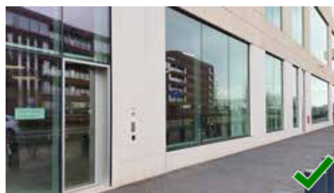
Entree fietsenstalling transparant vormgegeven (Gerechtsgebouw, Stationslaan)
