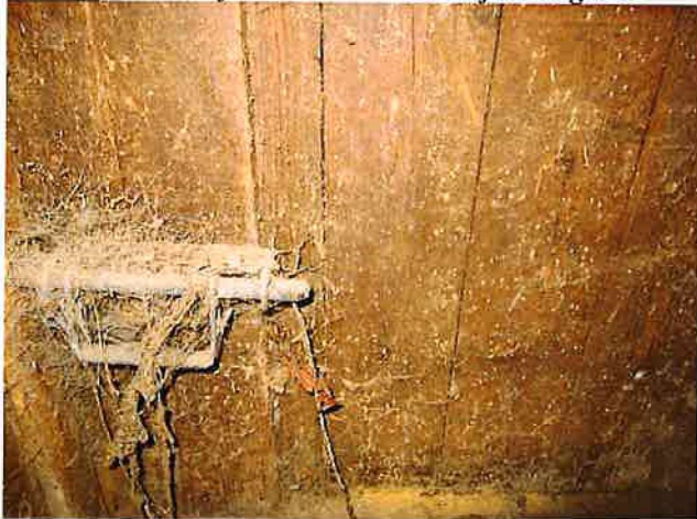
gevel no. 3: actieve houtwormaantasting (foto 2021)
