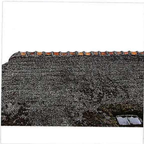
aanzicht rietvorsten dak no. 1 (foto 2020)
