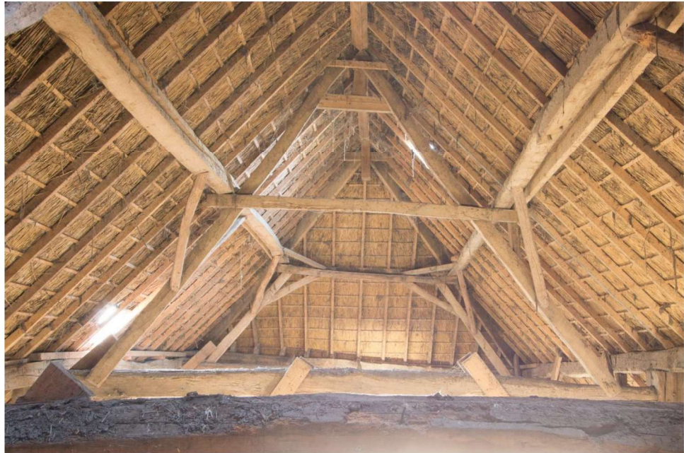
Kaspanten die later zijn geplaatst, vermoedelijk tweede helft negentiende eeuw.
