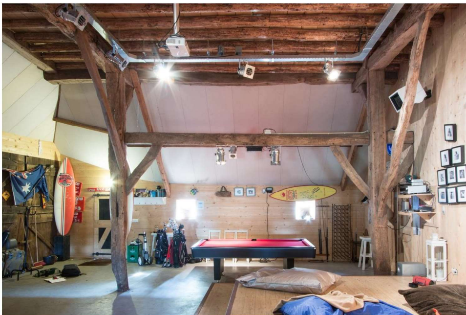
Eerste en tweede gebint gezien in de richting van de linkerzijde van de schuur. Steekrij met windverbanden in verband met het overstek in de linker zijbeuk.
