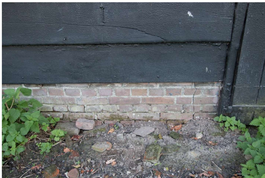
Metselwerk van de wandvoet, met machinaal geproduceerde baksteen (dus van na circa 1850).
