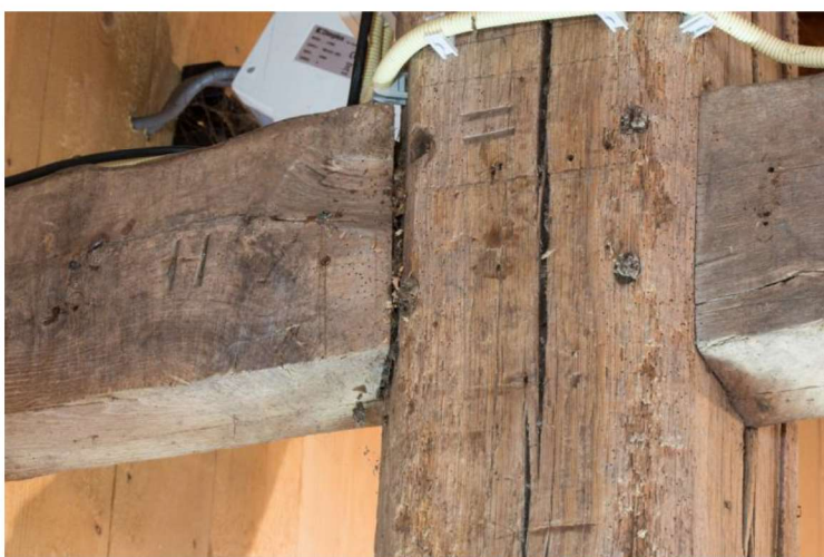
Kraslijnen en het gehakte telmerk II op stijl en steekrij.
