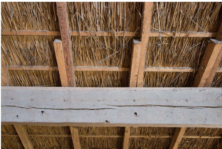
Ook in de gebintplaten toognagels voor verdwenen daksporen aanwezig. De huidige sporen zijn van vurenhout en zullen uit de tweede helft van de twintigste eeuw dateren. Vermoedelijk zijn ze aangebracht bij de laatste vernieuwing van het rieten dak.
