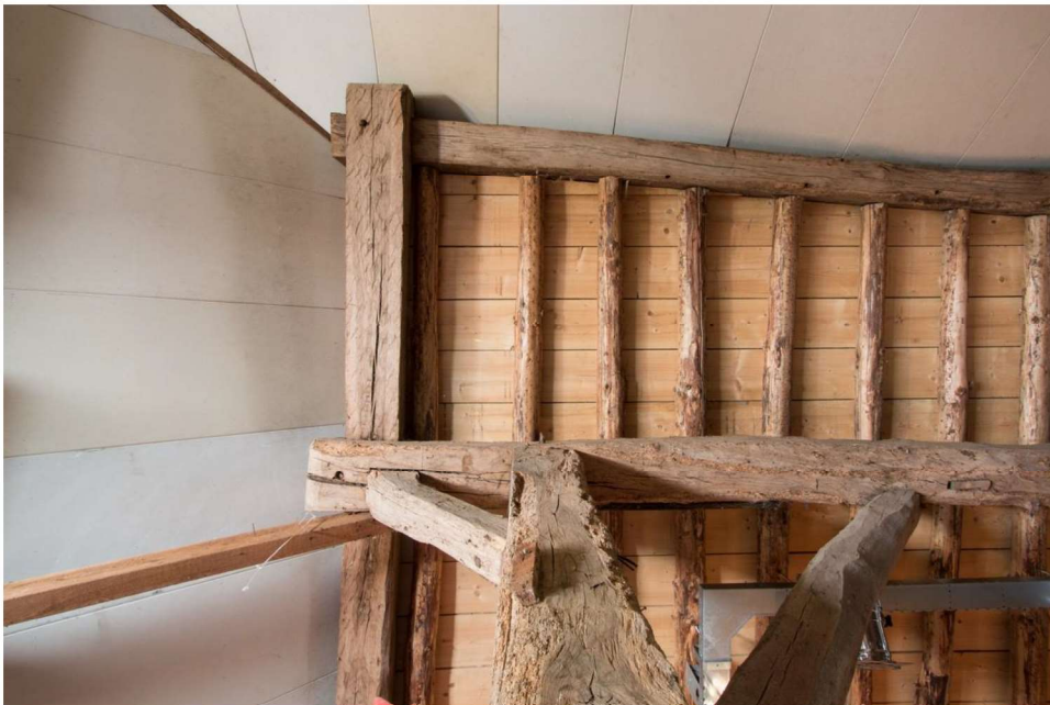
Secundaire zoldervloer ter isolatie van de ruimte.
