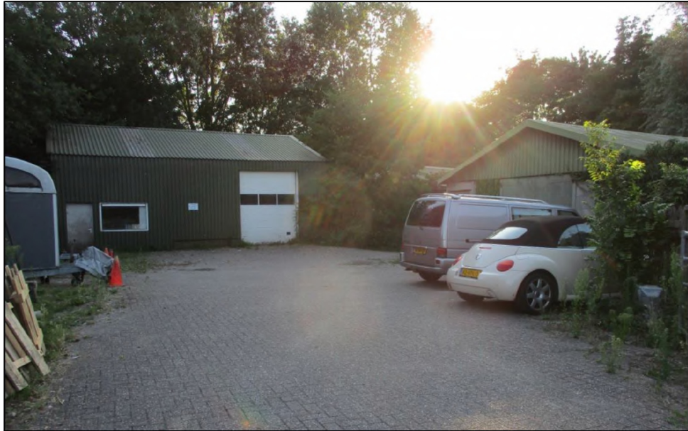
Figuur 1 De planlocatie is gelegen aan de Westeinderweg/Doctor van Noortstraat te Stompwijk en bestaat uit een aantal woningen en schuren, bosschage en een weiland.
