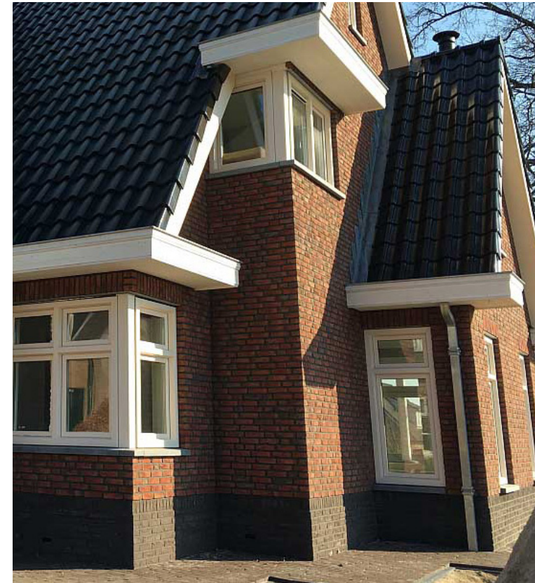
Donkere plint, daklijst met ruim overstek, uitbouw mee ontworpen
