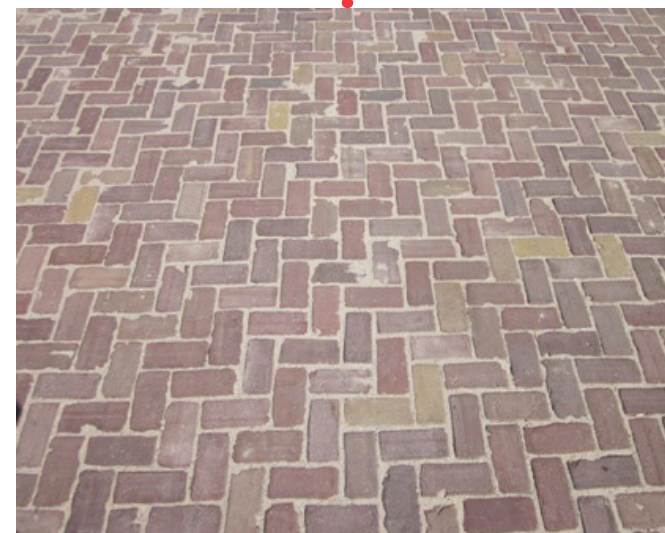
Rijbaan van gebakken klinkers (roob/bruin)
