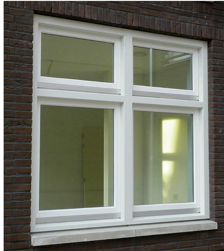
Raampartij bestaand uit meerdere kleine raamvlakken
