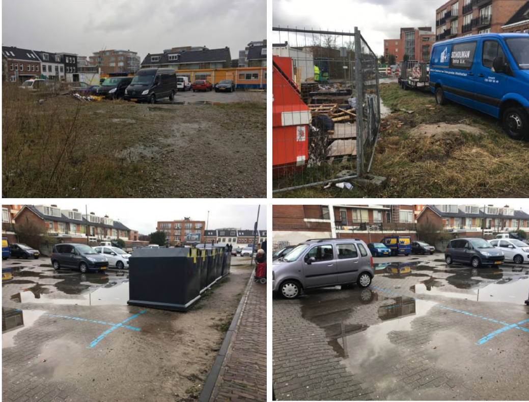
Figuur 3.3. Overzicht van deelgebied 2. Linksboven het aanzicht vanaf de Zaagmolenstraat. Hier is het onverharde gedeelte en de bouwkeet te zien. Rechtsboven het aanzicht vanaf het Molenpad. Dit is het aanzicht achter de bouwkeet, waar reeds werkzaamheden gaande zijn. Links- en rechtsonder het aanzicht vanaf de Damstraat. Hier is de parkeerplaats te zien.
