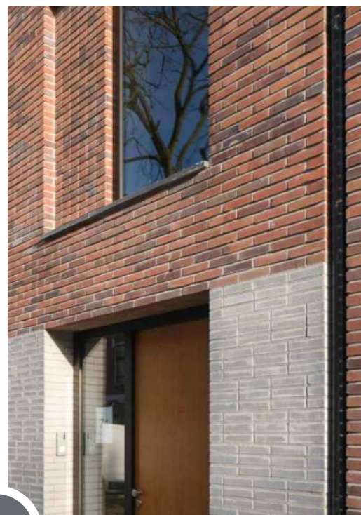
combineren van metselwerkverbanden
