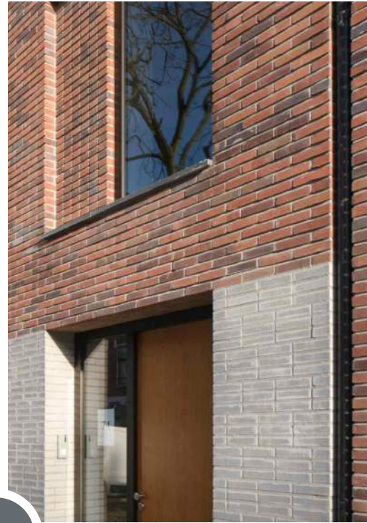
combineren van metselwerkverbanden
