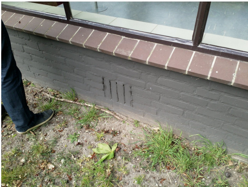
Ventilatievoegen laag bij de grond in een deel van bouwdeel K.
