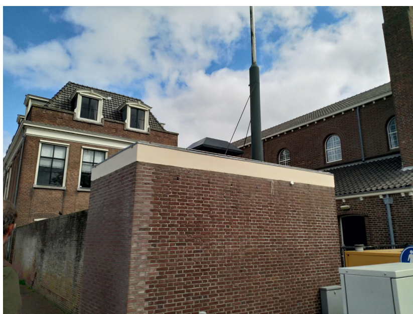
Bouwdeel K in het zuidwestelijke deel met open stootvoegen.
