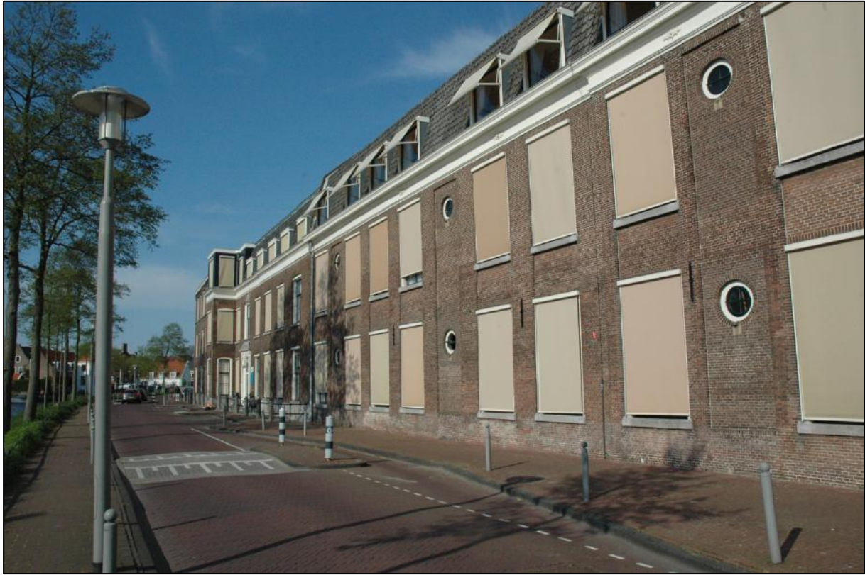
Afb. D1: De Rijengevel van gebouw D telt tien traveeën. De tweede verdieping lijkt door zijn (valse) dakschild een zolder.
