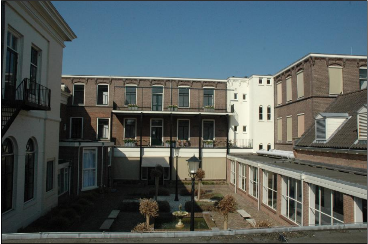
Afb. C4: De gebouwen rondom de noordelijke van de twee binnenhoven. Centraal de achtergevel van bouwdeel C. Links de noordgevel van Mutua Fides met de erker van bouwdeel H erachter. Rechts bouwdeel B en bij de fotorand gebouw J met aangebouwde gang (K).
