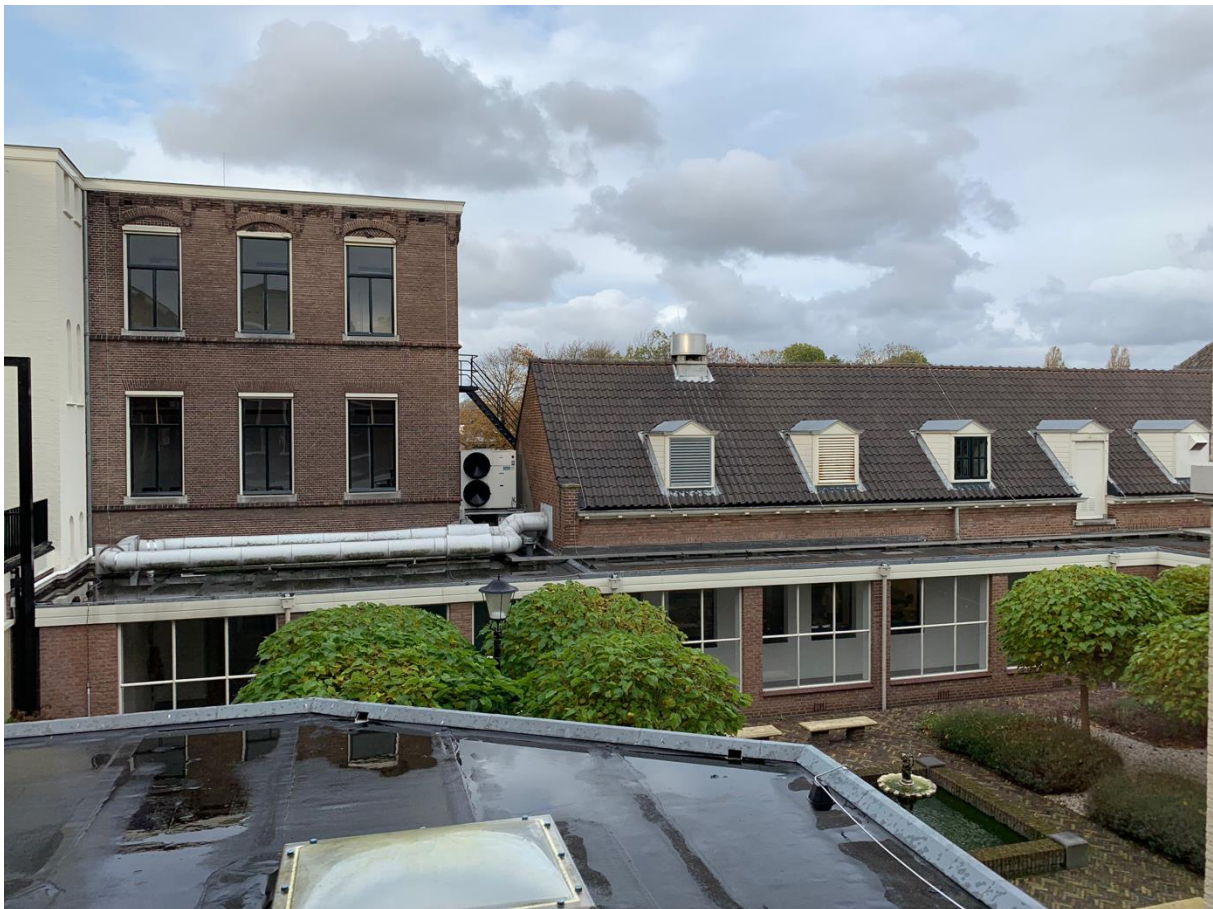
Figuur 2.1: Gebouw vanuit het westen. De begane grond is achter de buitengang verborgen. Bron: Bouwhistorische inventarisatie Veerman.
