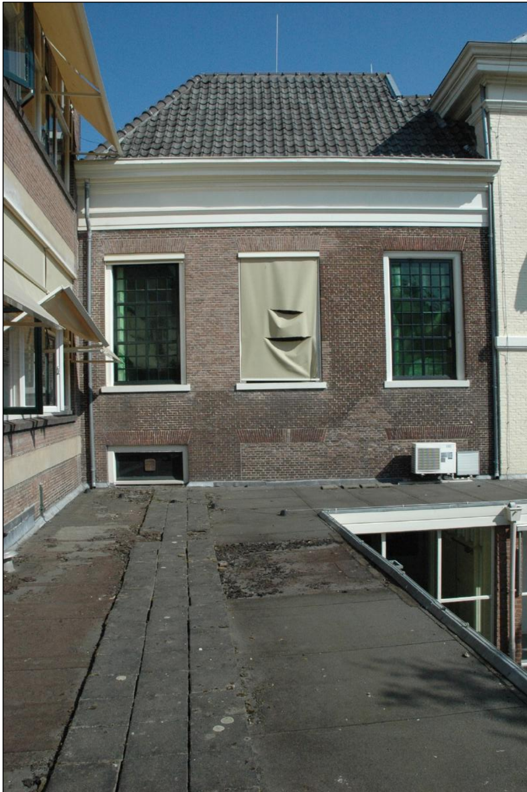
Afb. I7: De zuidgevel van bouwdeel I b. Het 19de-eeuwse metselwerk in zuiver kruisverband laat zich redelijk makkelijk onderscheiden van latere herstelling, onder andere rondom het linkse en middelste venster. Daar heeft in de eerste helft van de 20ste eeuw enkele decennia een groot venster gezeten.
