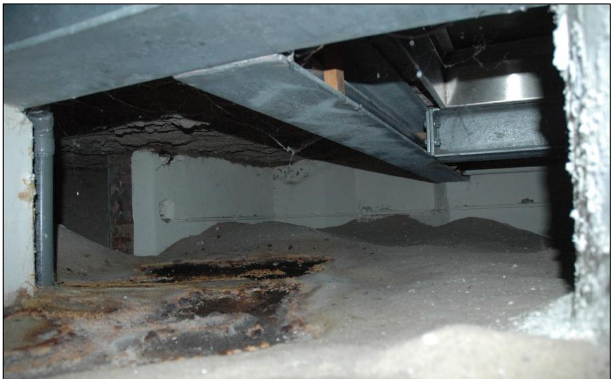
Afb. C8 [O]: Foto in de grotendeels met zand gevulde kelder, richting linksachter. Links zien we een doorgang in de zijwand, mogelijk naar een volgende historische kelderkamer. In de achterwand is een nis met schuine dagkanten te zien, restant van een uitgang of venster aan de tuinkant. De naar achter lopende balk steekt in de rechtse dagkant.
