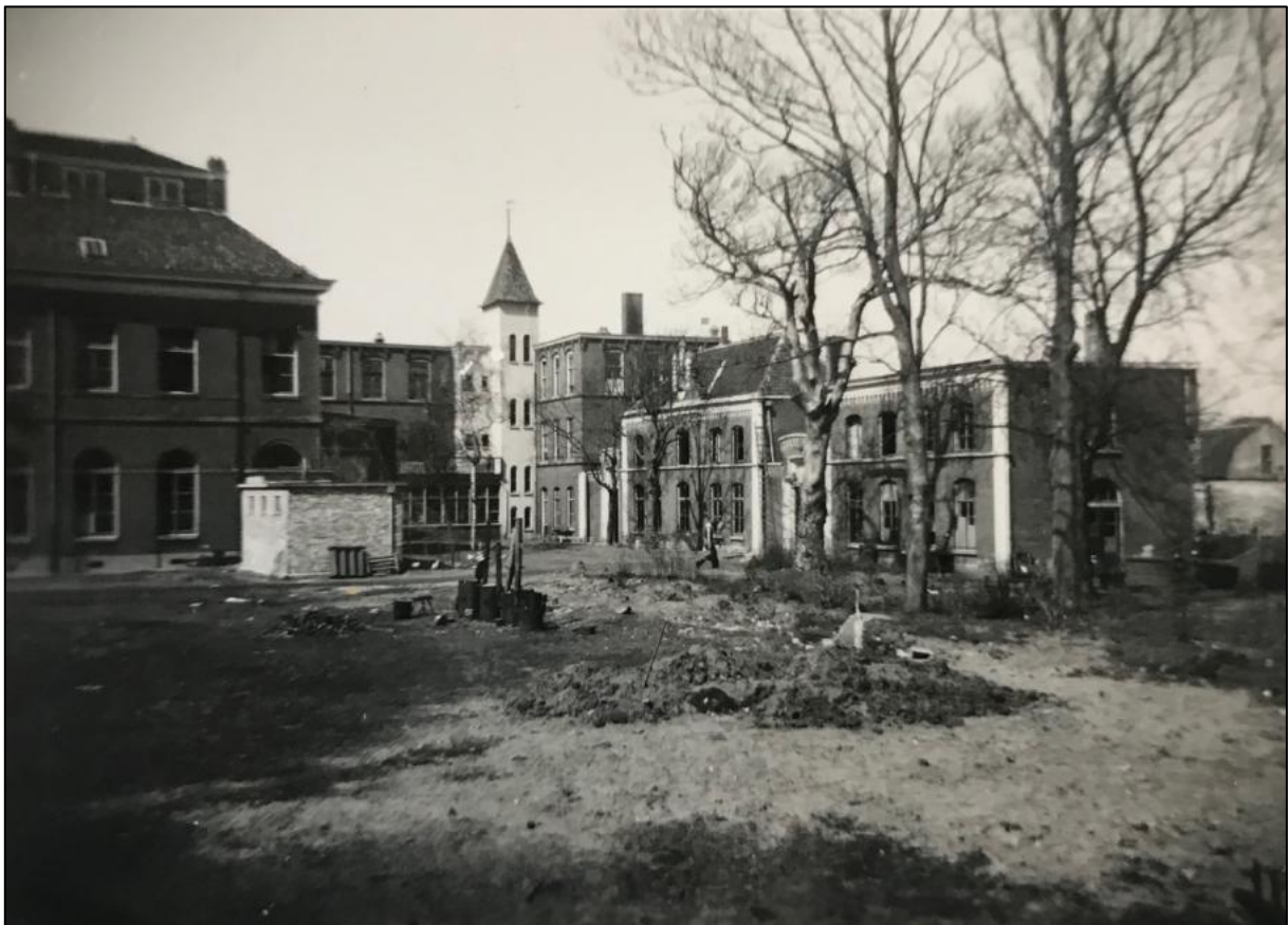
Afb. V34: De situatie na de Tweede Wereldoorlog, zoals in 1949 gefotografeerd door het bureau van architect Van der Lubbe. Van links naar rechts gebouwen G (Mutua Fides), B, J en A. [HNI Rotterdam]
