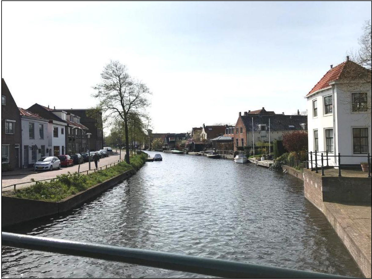
Afb. V16 [B]: Zicht vanaf de moderne brug op het brughoofd dat resteert van de 17de-eeuwse stenen brug. Verderop aan de linkerkzijde staat Het Hof, beginnend bij het blokvormige bouwdeel naast de boom.
