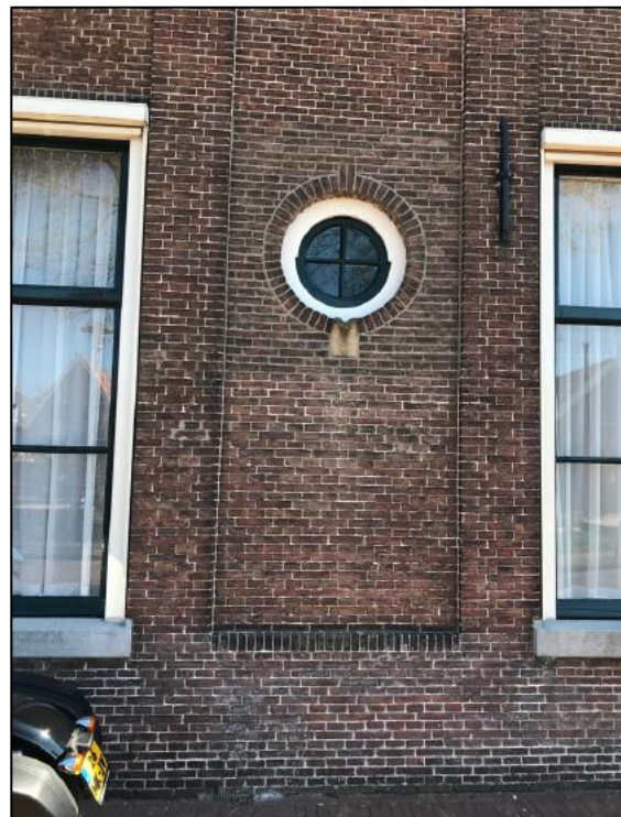
Afb. D2: De plint van de voor- of Rijengevel bevat ouder metselwerk dan de opgaande muur. De rondvensters zijn naorlogs. Dat verklaart het afwijkende voegwerk rondom die vensters.
