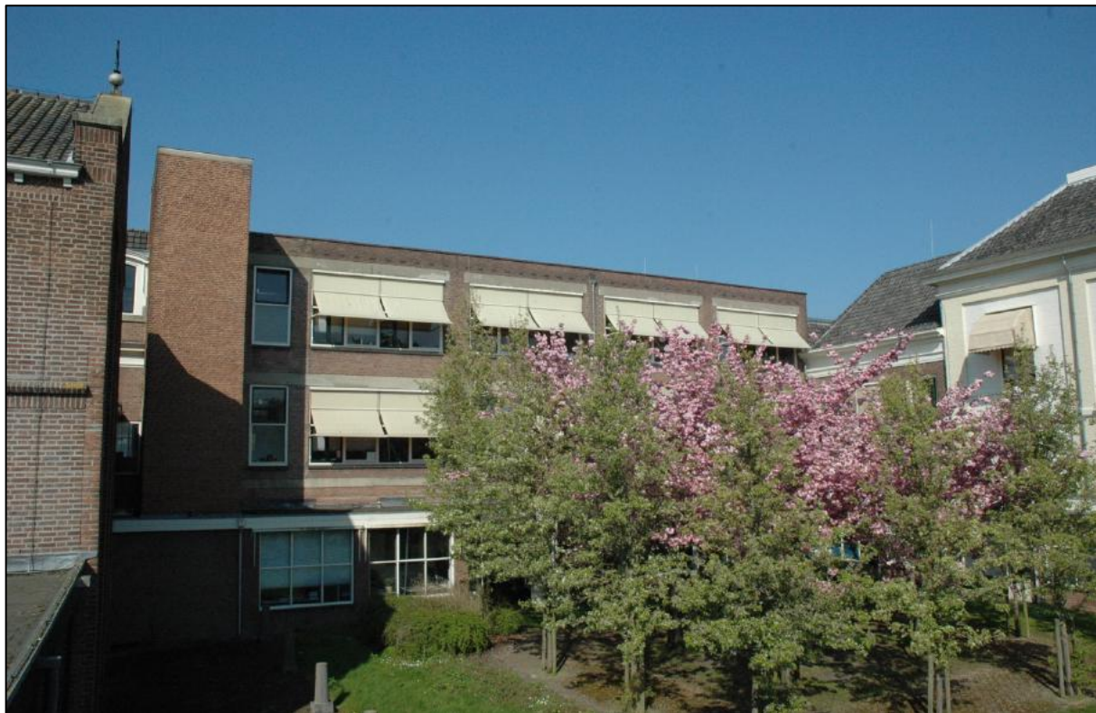
Afb. D9: Zicht op de achtergevel van bouwdeel D. Links de latere liftschacht en de kapel (F) en rechts nog stukjes van gebouwen G en I.
