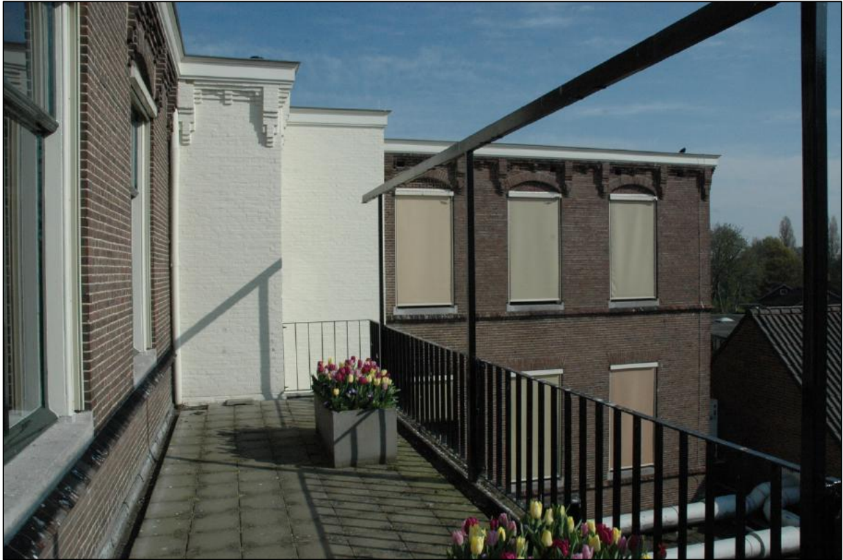
Afb. B16: Zicht op de binnenhoek van gebouw B, aan de zuidkant.
