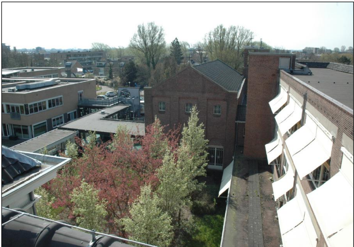
Afb. 11: Vanaf het dak van gebouw I (b) naar de achtergevel van gebouw D en de noordgevel van de kapel (F).
