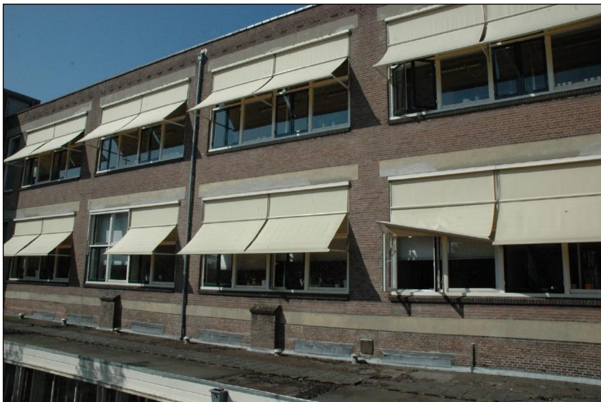
Afb. D10: De achtergevel van bouwdeel D is beneden inpandig, de bovendaks zichtbare eerste en tweede verdieping laten metselwerk, betonbanden en vensters zien van rond 1950. In de borstwering onder de eerste verdiepvingsvensters zien we met lood afgedekte vensterdorpels. Daartussen bevindt zich ouder muurwerk.
