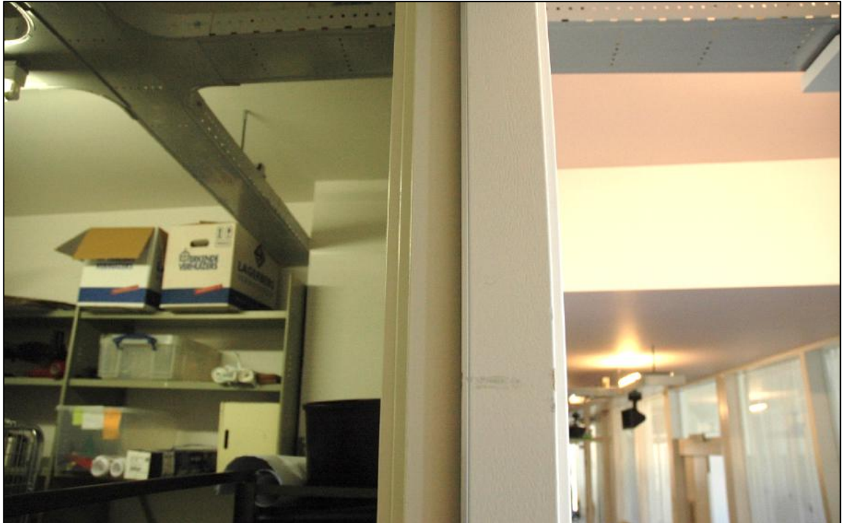
Afb. 18: Het lage bouwdeel tussen bouwdelen I en G wordt voor de vorm tot Gebouw G gerekend. De hier getoonde wand – de voorwand van ruimtes G0.02 [L] en G0.01 kan nog minieme delen van de oudste tuingevel van gebouw I bevatten.
