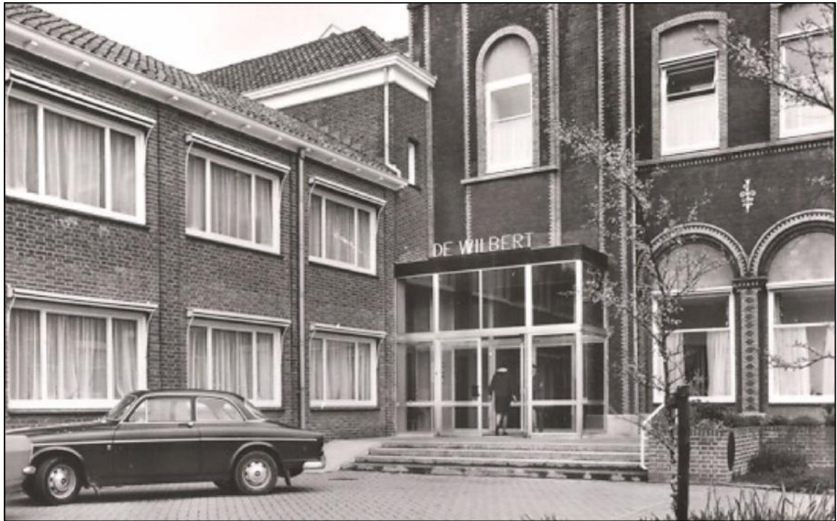
Afb. V37: De Wilbert bouwde het markante 19de-eeuwse gebouw Kleinenburg (later Middelburg genoemd) om tot hoofd- en entreegebouw. Het is rond 2000 gesloopt en ingeruild voor nieuwbouw ter plaatse. Links op de foto de verbindingsgang in de stijl van Van der Lubbe (ca. 1952). De vormgeving in staal en glas daarvan en van de portiek komen we nu nog tegen bij verbindingsgangen, onderdeel van de verzamelcategorie K.
