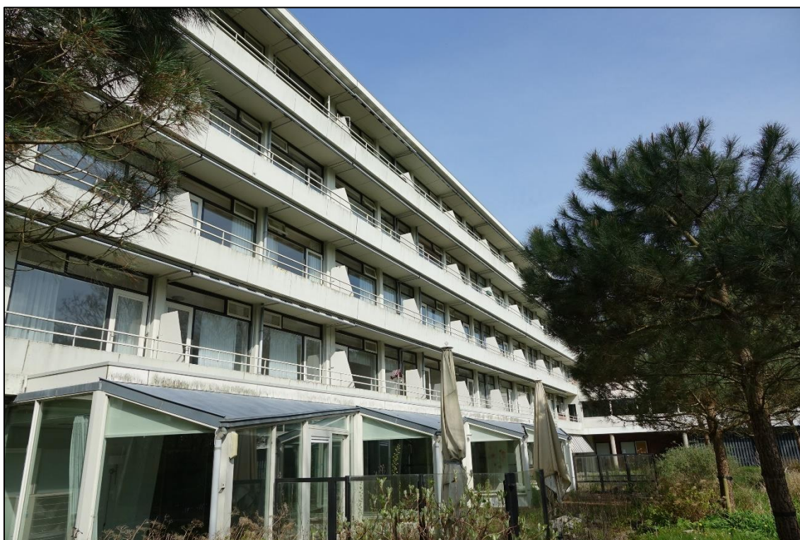
Figuur 3: Achterzijde wooncomplex met veel balkons en relingen.
