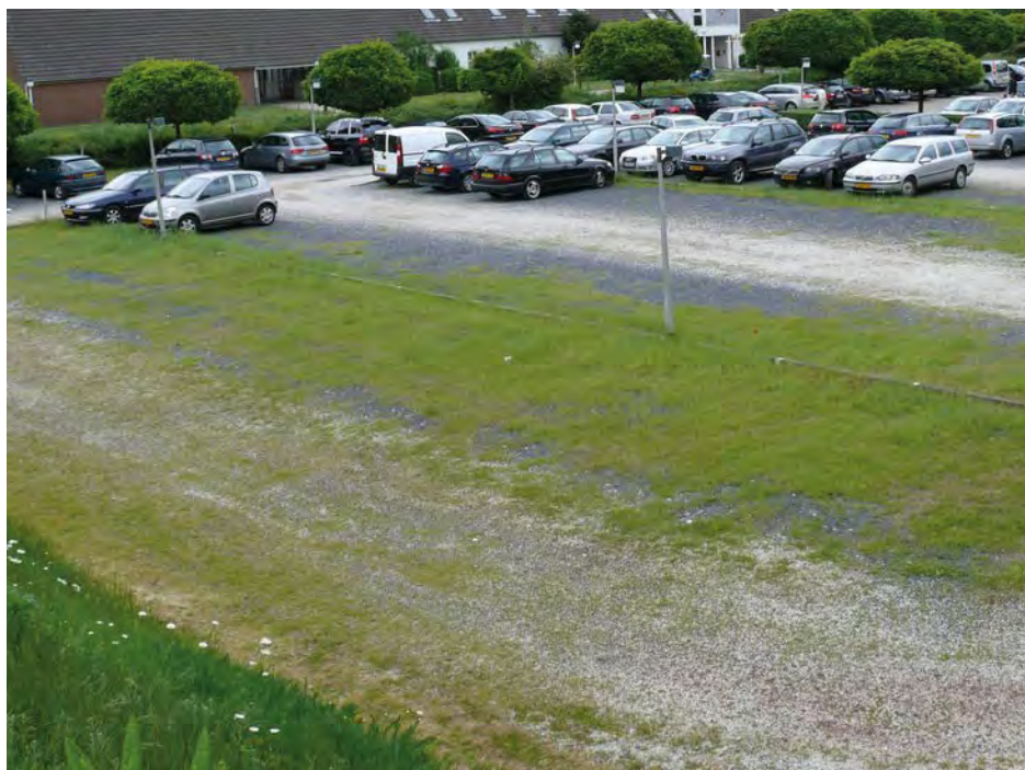
Tijdelijke parkeerplaats in halfverharding
