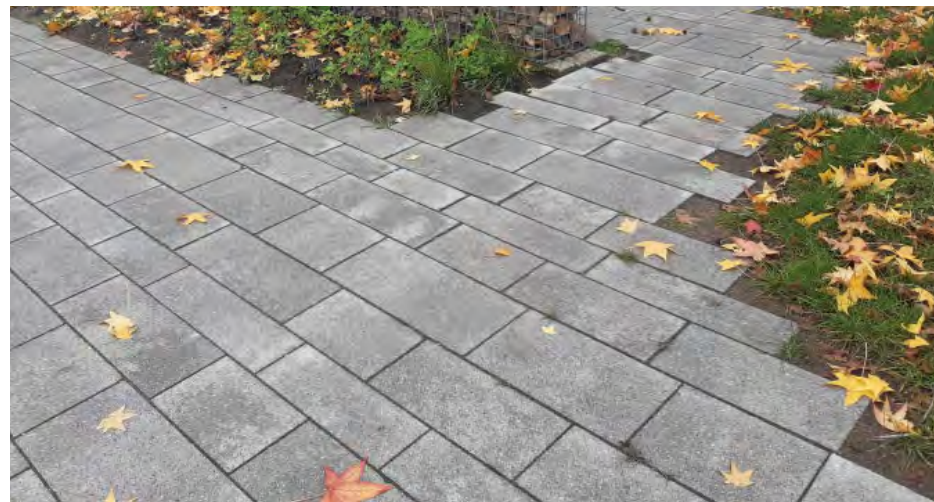
Klostermann Finerro SCADA, aangelegd met ‘rafelige’ randen
