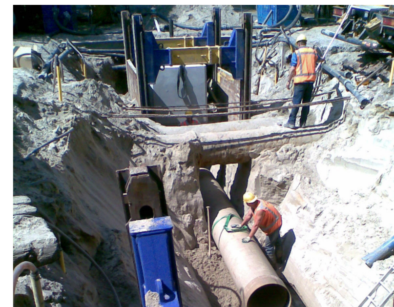
Figuur 1: werkzaamheden in gemeente Heemstede
