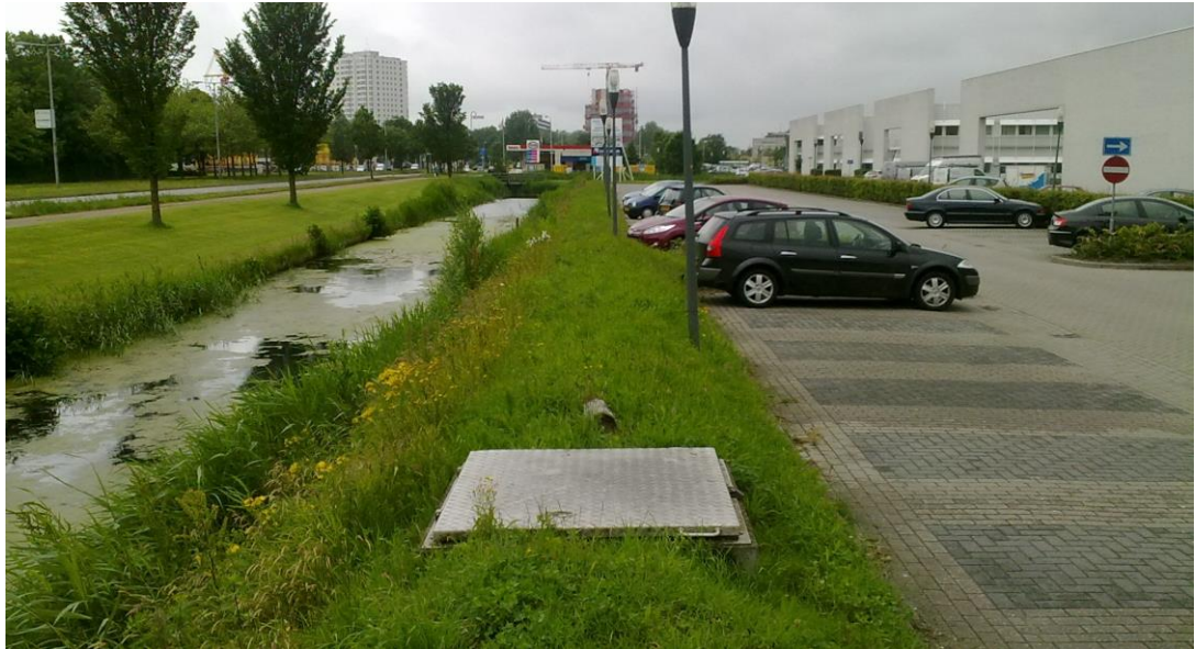
Figuur 1 | Voorbeeld afwerking halfbovengrondse putbehuizing
