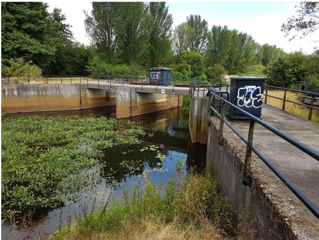
Figuur 2.10 Voormalige stuw Archem
