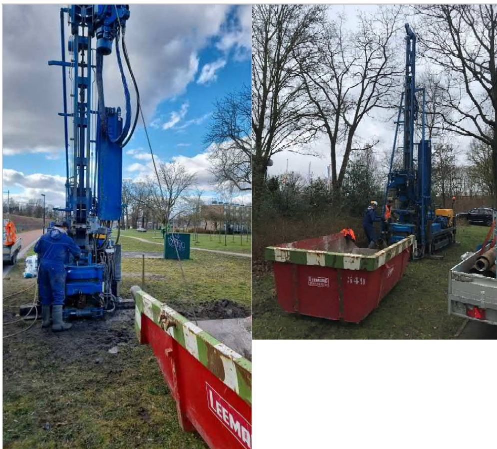
Foto's plaatsing peilbuis
