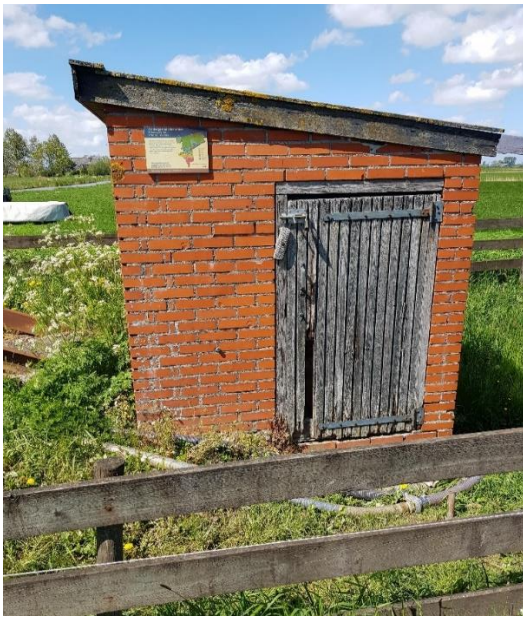
Gemaal Het Oude Anker, Bovenbouw
