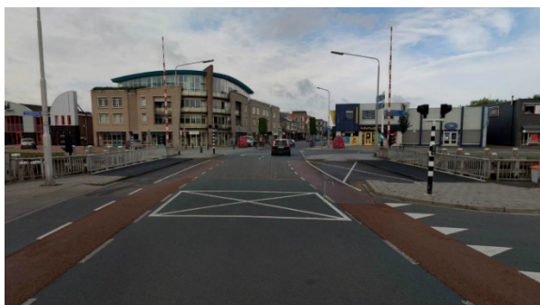
Kruispunt, komend vanuit oosten (Tonnendijk)
