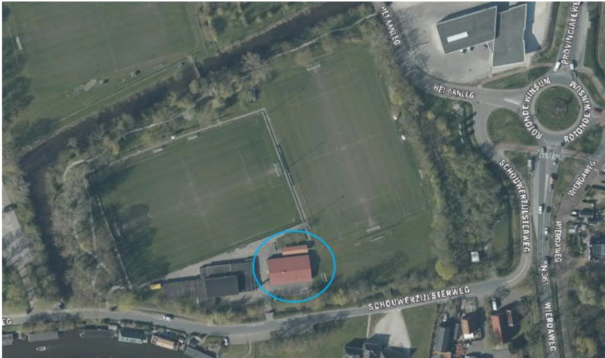
Figuur 1. Blauw omcirkeld de te slopen voormalige sportkantine, met links daarvan een monumentale gymzaal.
