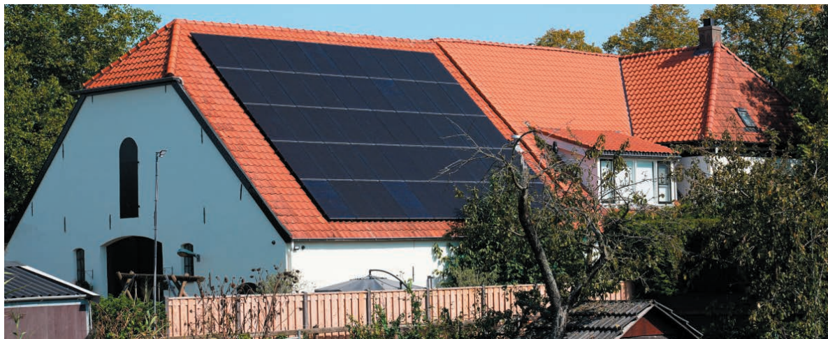
Afbeelding 5.36 Zonnepanelen op het dak
