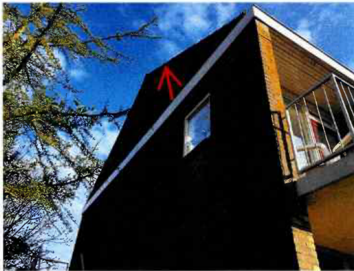
Figuur 1: Locatie nest huismus bij appartementencomplex Hoofdweg 82-90 in Zegveld.
