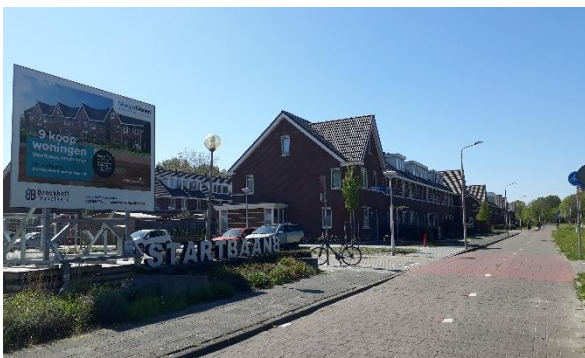
Figuur 4: Nieuwbouw Startbaan
