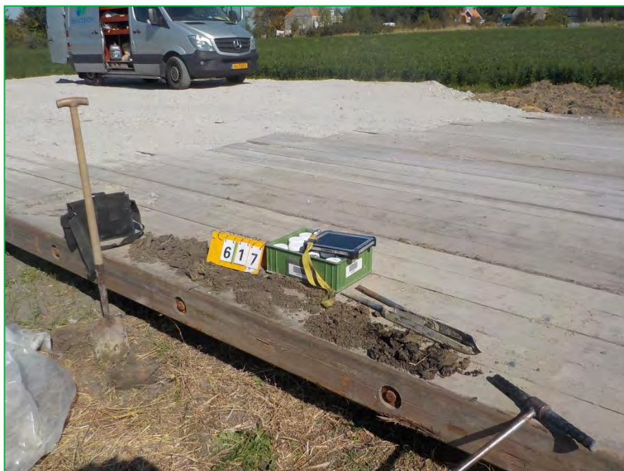
Foto 4. Boring 617 staat juist naast de werkweg.
