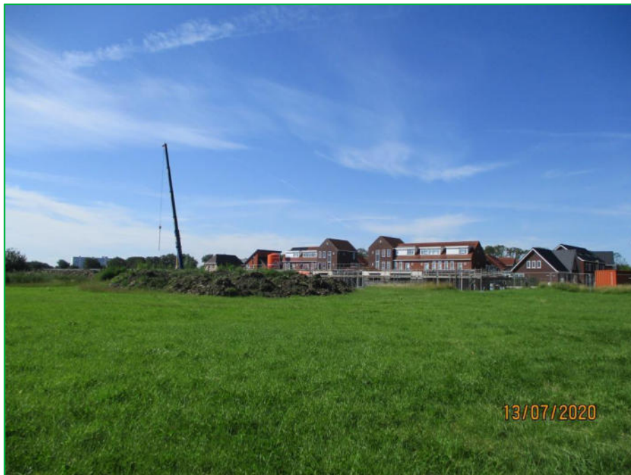
Foto 1: Noordelijk terrein richting woonwijk in aanbouw
