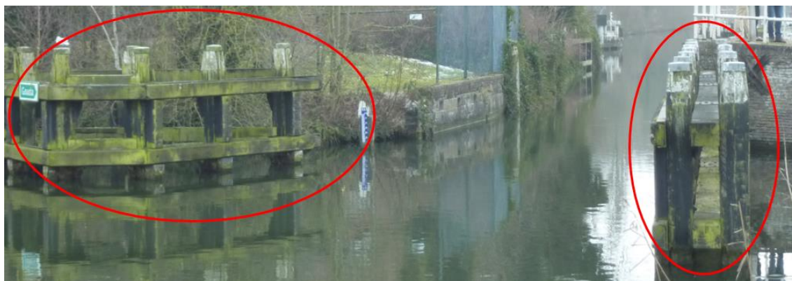
Figuur 8: De remmingwerken aan Merwedezijde bij de ingang van de Doorslag
