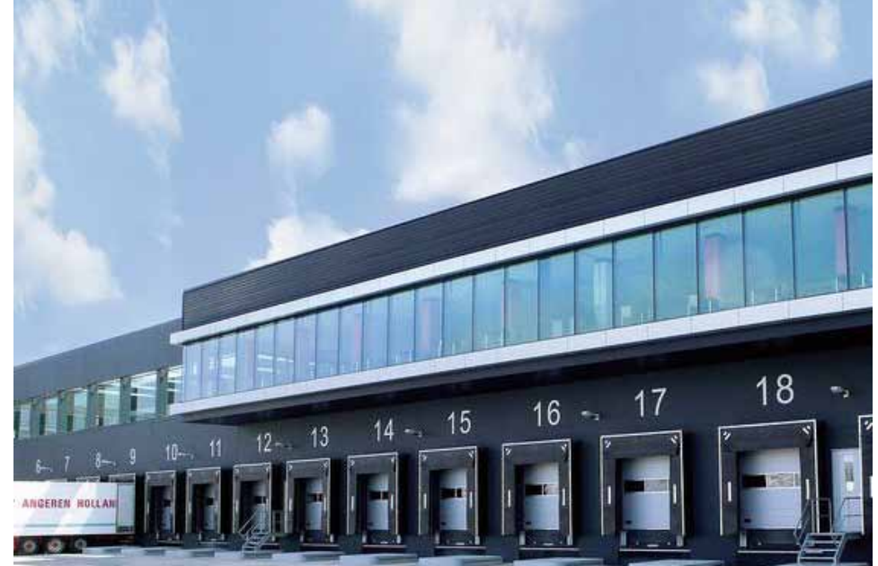
loading-docks met daarboven kantoor
