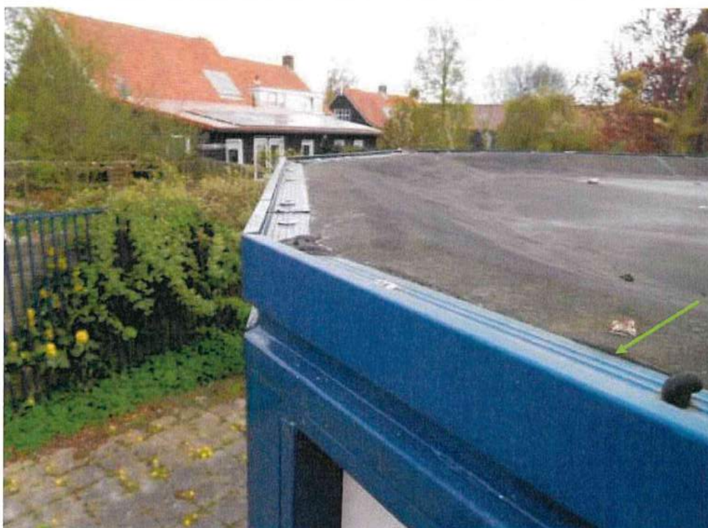
Foto 2 Niet asbesthoudende kit dakrand (M02)
