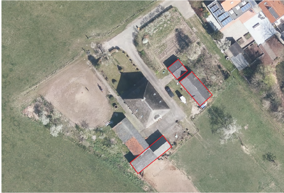
Afbeelding 11 - Te slopen bebouwing rood omlijnd
