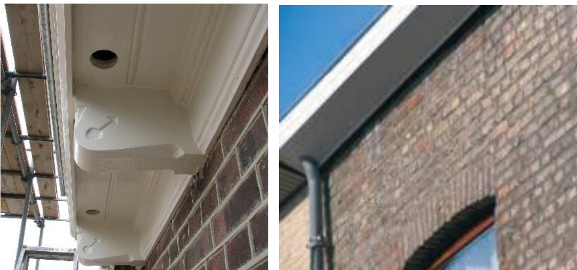
Figuur 15 Ruimte voor gierzwaluw in de gootbekisting of achter de dakgoot (bron: gierzwaluwbescherming en kennisdocument BIJ12).
