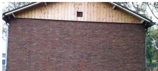
Figuur 12 Voorbeeld van gevelbetimmering die geschikt is voor vleermuizen. Bron: vleermuizenindestad.nl en checklistgroenbouwen.nl
