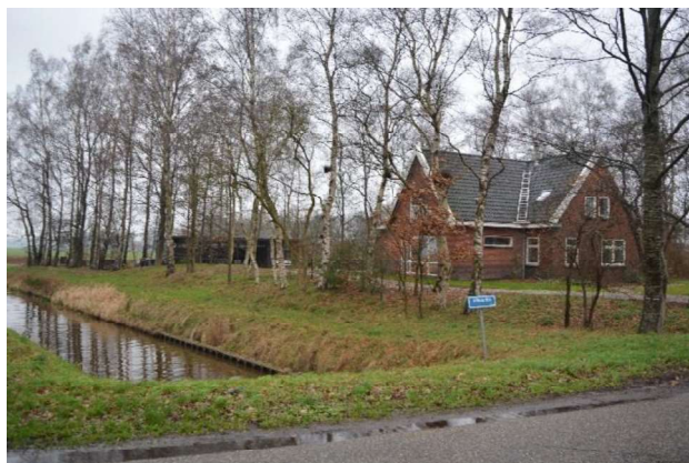
Achterste Diep t.h.v. Drouwenerstraat in noordelijke richting
