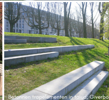
Betonnen trapelementen in talud; Giverbo
