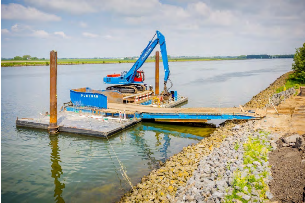
Figuur 2.64 Impressie van een tijdelijke aanlegplaats
