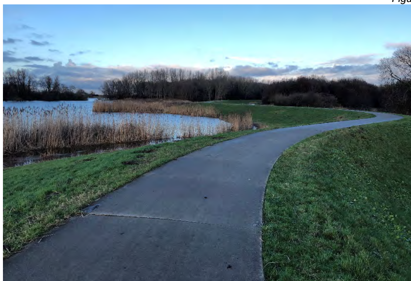
Foto 2.49 Waterkering langs de Westerveldse kolk
