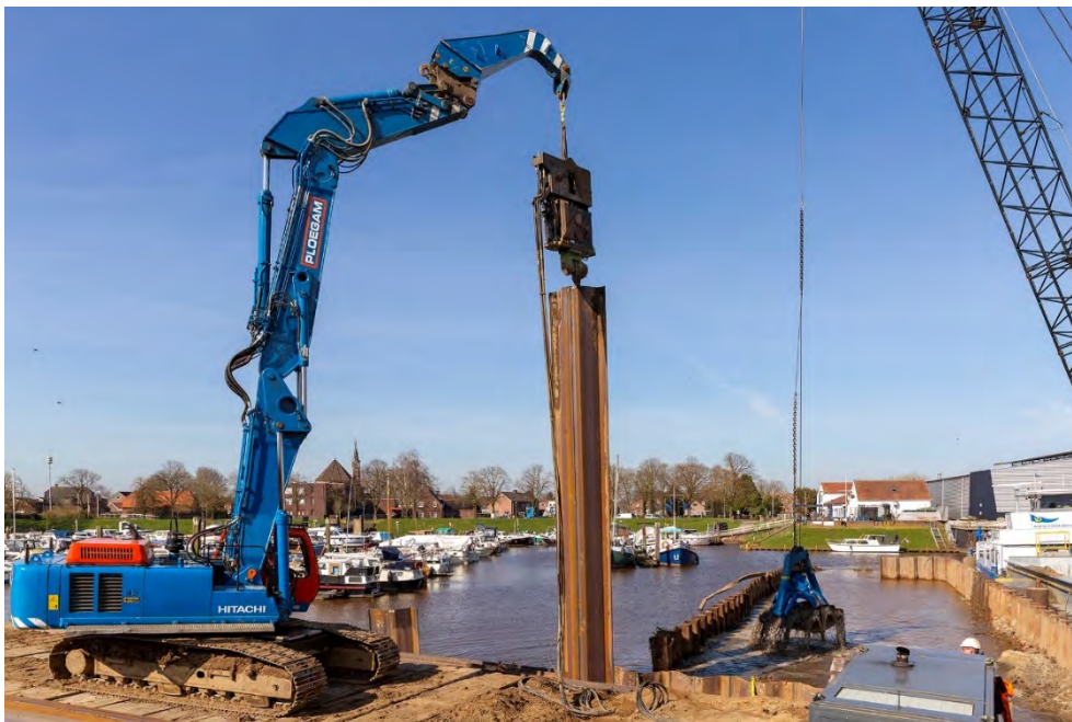
Figuur 2.61 Impressie van het aanbrengen van damwanden
