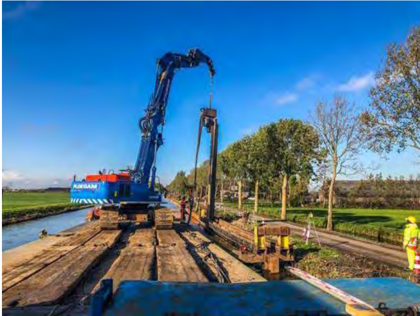
Figuur 3.1 Aanbrengen damwanden met een graafmachine op rupsbanden plus trilblok op een duwboot
