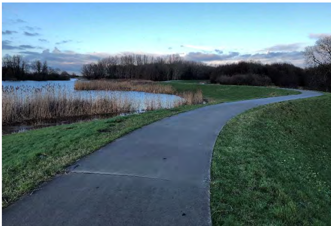
Foto 2.7 Waterkering langs de Westerveldse kolk
