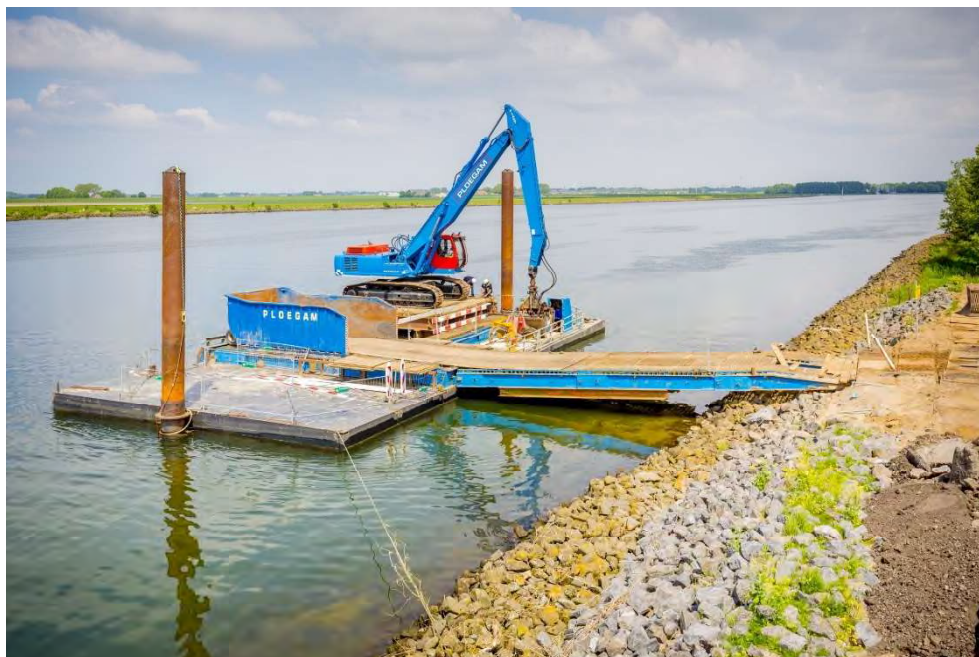
Figuur 2.21 Impressie van een tijdelijke aanlegplaats
