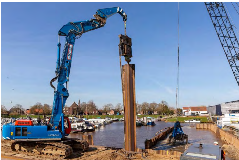
Figuur 2.19 Impressie van het aanbrengen van damwanden
