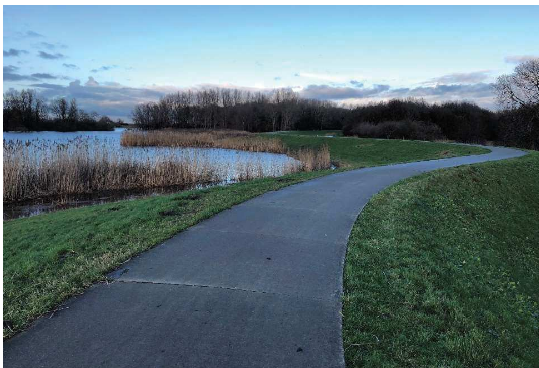
Foto 2.7 Waterkering langs de Westerveldse kolk
