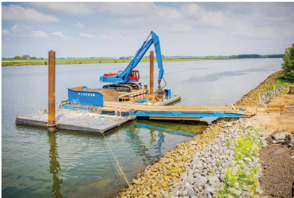
Figuur 6.2 voorbeeld Laad – los voorziening
