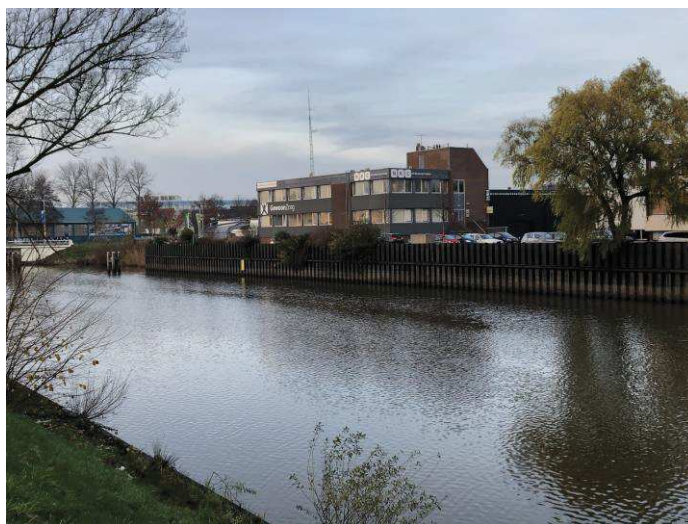
Foto 7.1: Huidige damwand A28 Zwarte Water
