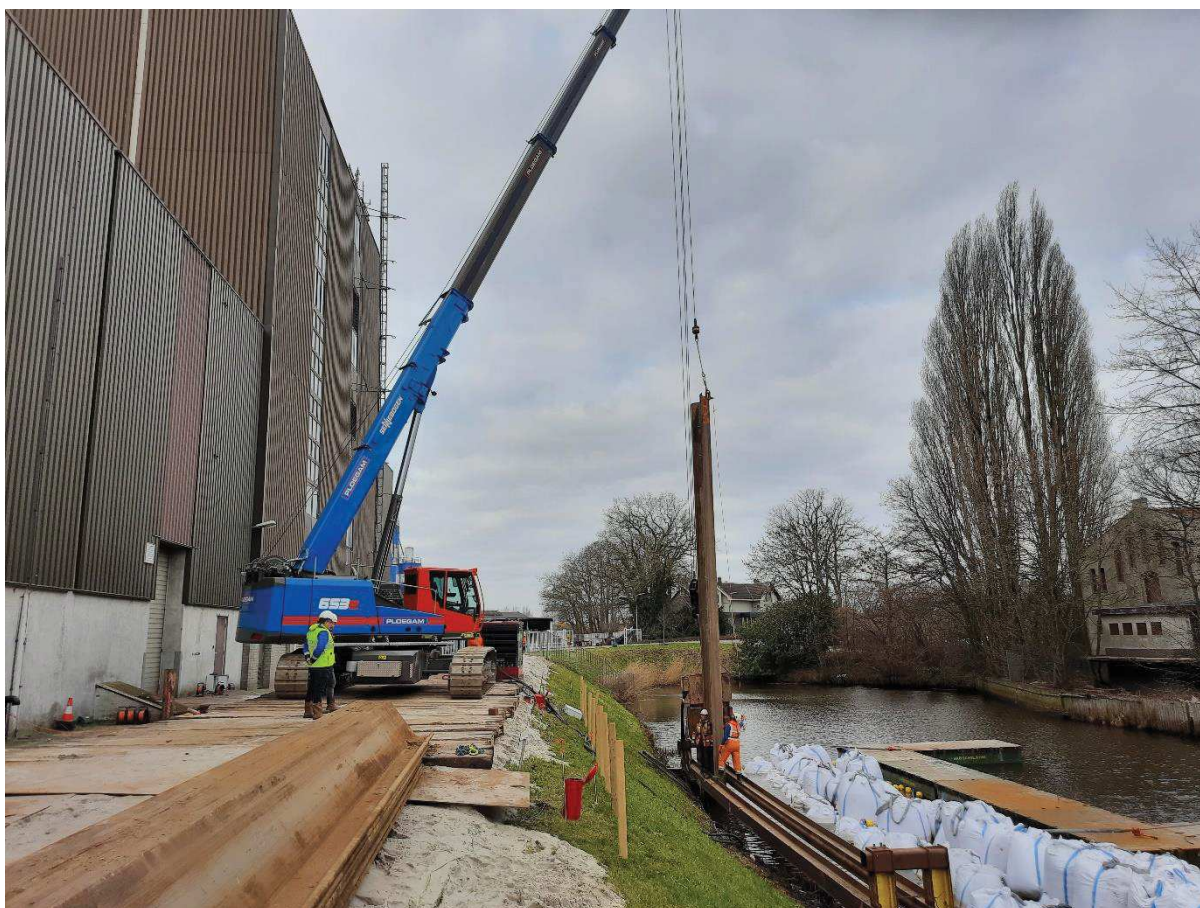
Figuur 7.20 Hei- / uitvoeringsproef DT2B "Balkengat" februari 2021
