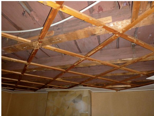
Afb. 17 De geschilderde balklaag in de rechtersvoorkamer op de eerste verdieping
