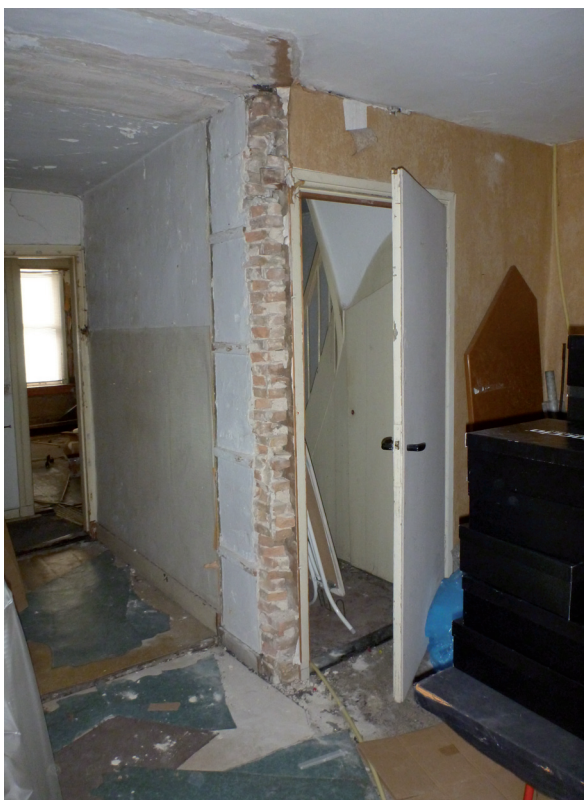
Afb. 18 De deur naar de overloop met links daarvan de aanzet van een verdwenen halfsteenscheidingswand
