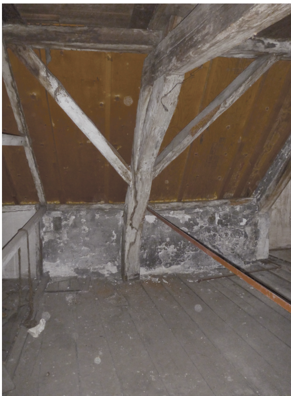
Afb. 23 Een van de hergebruikte eiken spanten
