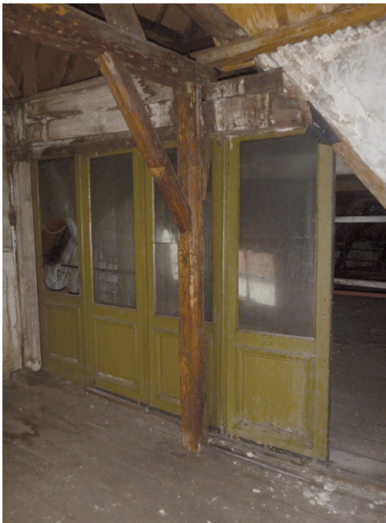
Afb. 22 De (hergebruikte) wand met glaspaneeldeuren op de scheiding van de zolders van het voor en achterhuis
