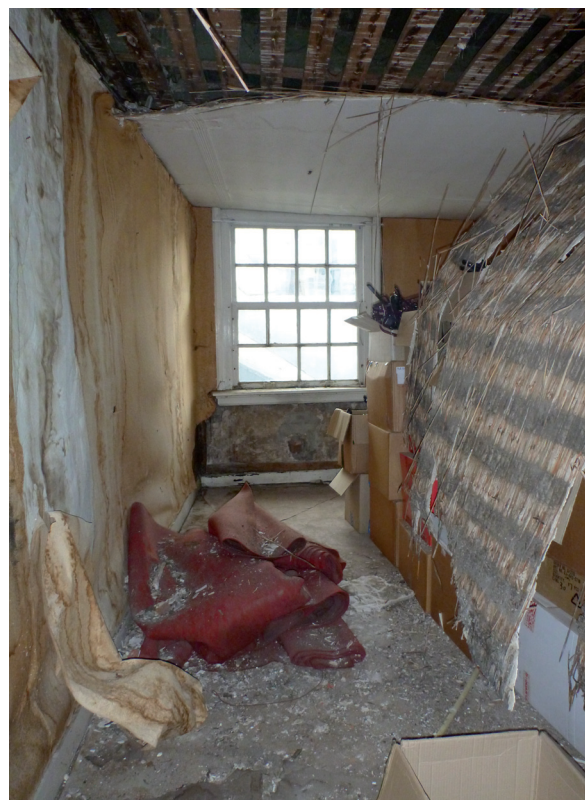
Afb. 19 Het stucplafond in de achterkamer van het achterhuis
