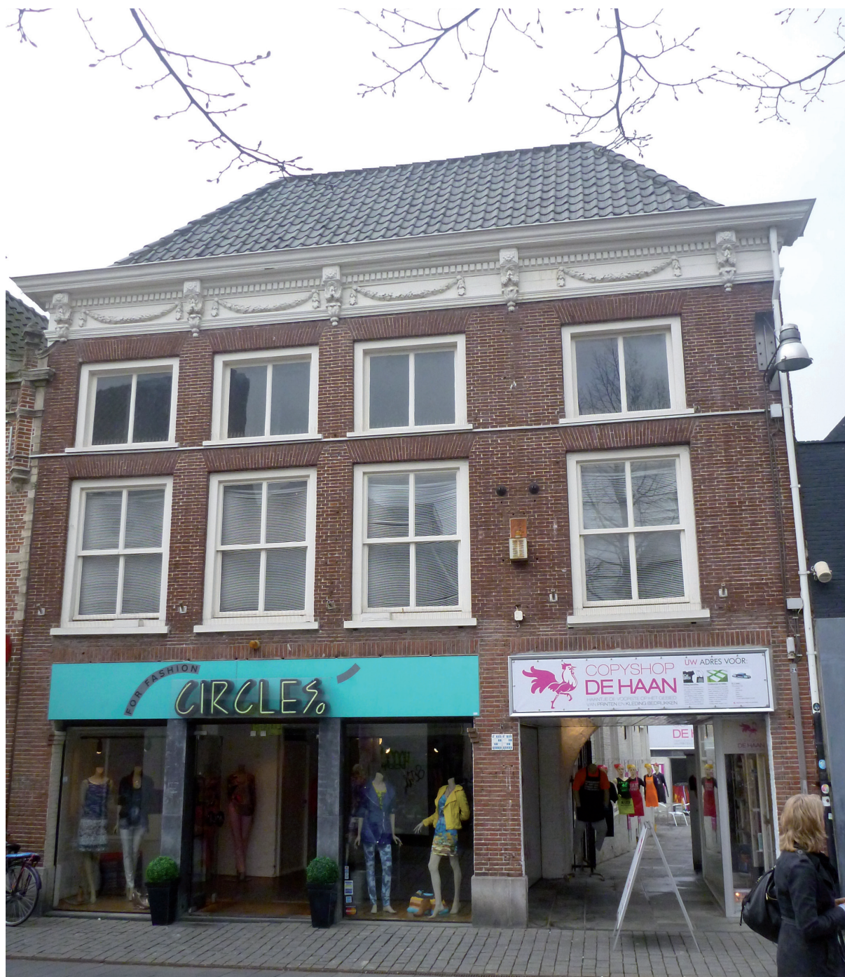
Afb. 7 De voorgevel gezien vanuit de Stallingstraat
