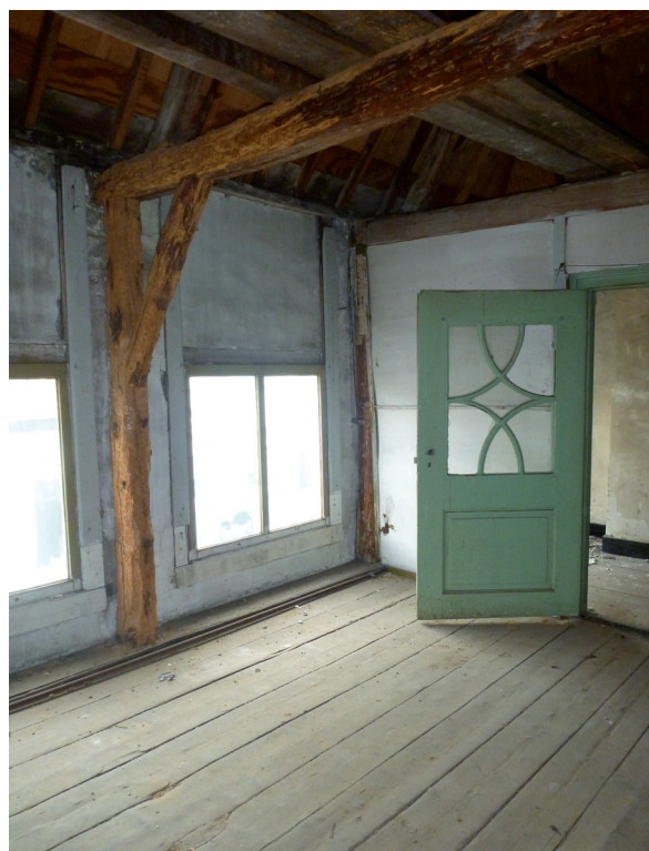
Afb. 21 De zolder boven het voorhuis met de gebintconstructie en de achter de gevellijst schuivende ramen van de vensters op de tweede verdieping
