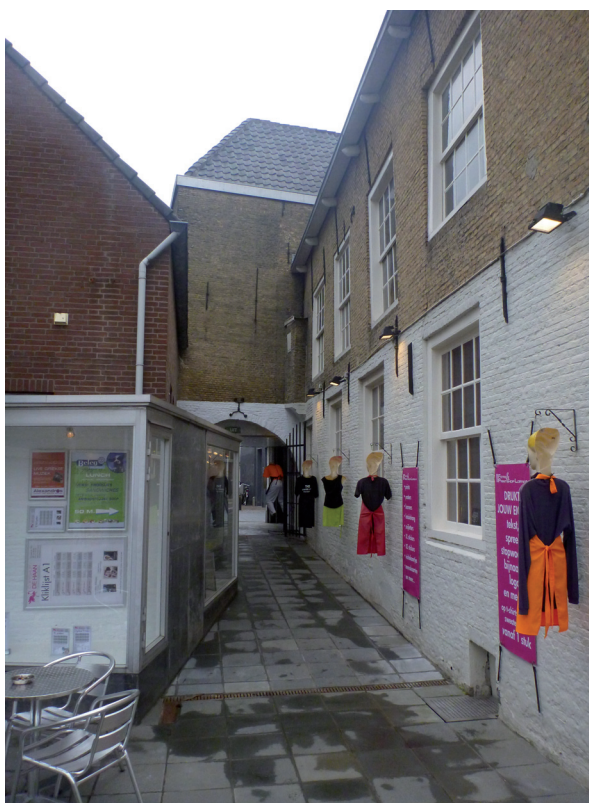
Afb. 9 De rechterzijgevel van het achterhuis met op de achtergrond de poortdoorgang naar de Ginnekenstraat
