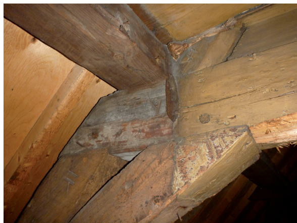
Afb. 24 De gehakte telmerken van een van de voorste spanten van het achterhuis
