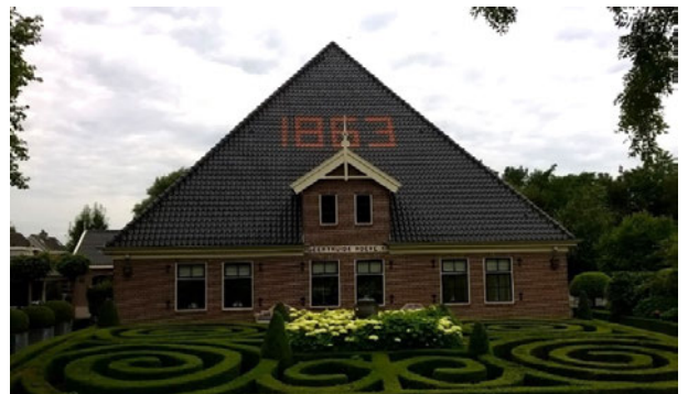
Stolpboerderij aan Westerweg 59
