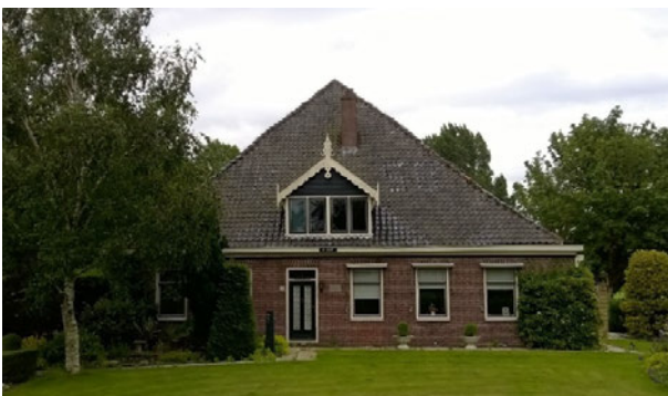
Stolpboerderij aan Westerweg 28
