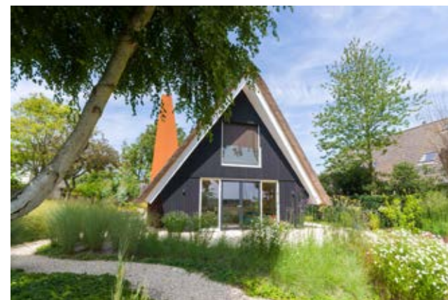
Bebouwing op enige afstand van de weg
