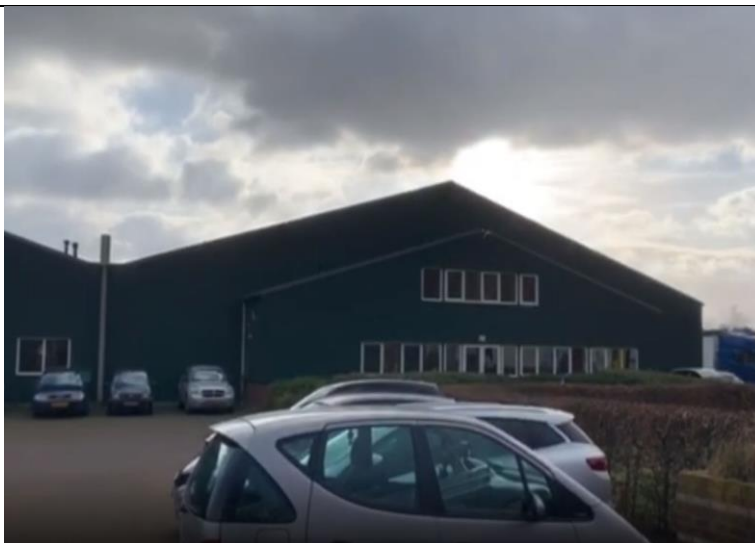
Vooraanzicht met kantoor/opslaggebouw
