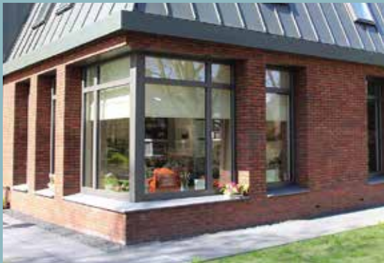
▲ hoekvensters, diepe negge
