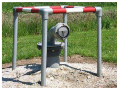
Figuur 2: vaste bovengrondse aansluiting gesloten geboorde put.
