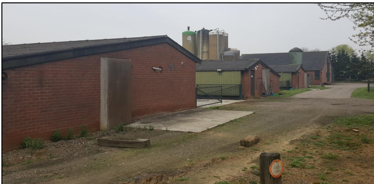
Afbeelding; de drie te slopen stallen
