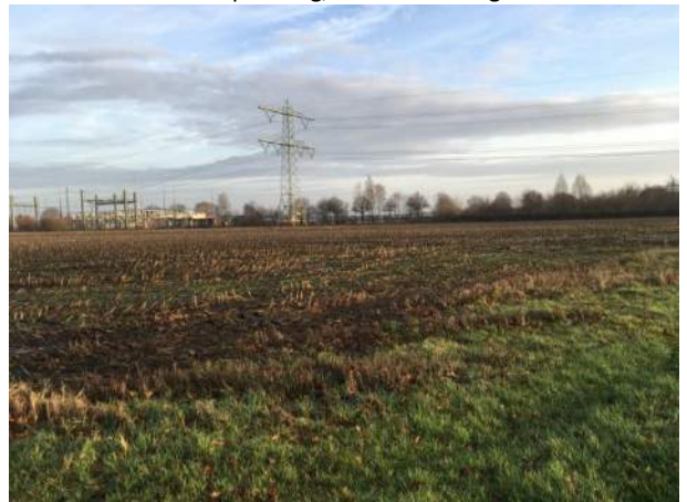
Foto 12 Uitzicht op hoogspanningsleiding en verdeelstation Enexis
