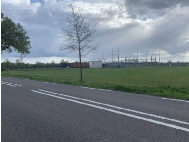
Foto 13 Verdeelstation Enexis gelegen aan de Horserweg
