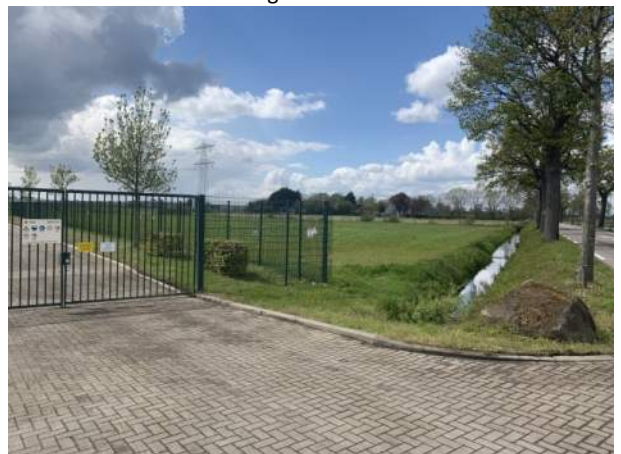
Foto 12 Verdeelstation Enexis gelegen aan de Horsterweg
