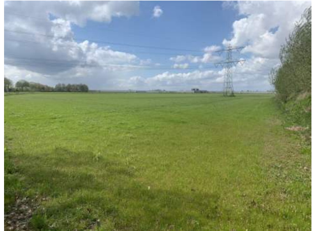
Foto 8 Aanzicht hoogspanningsleiding vanuit Sevenumseweg
