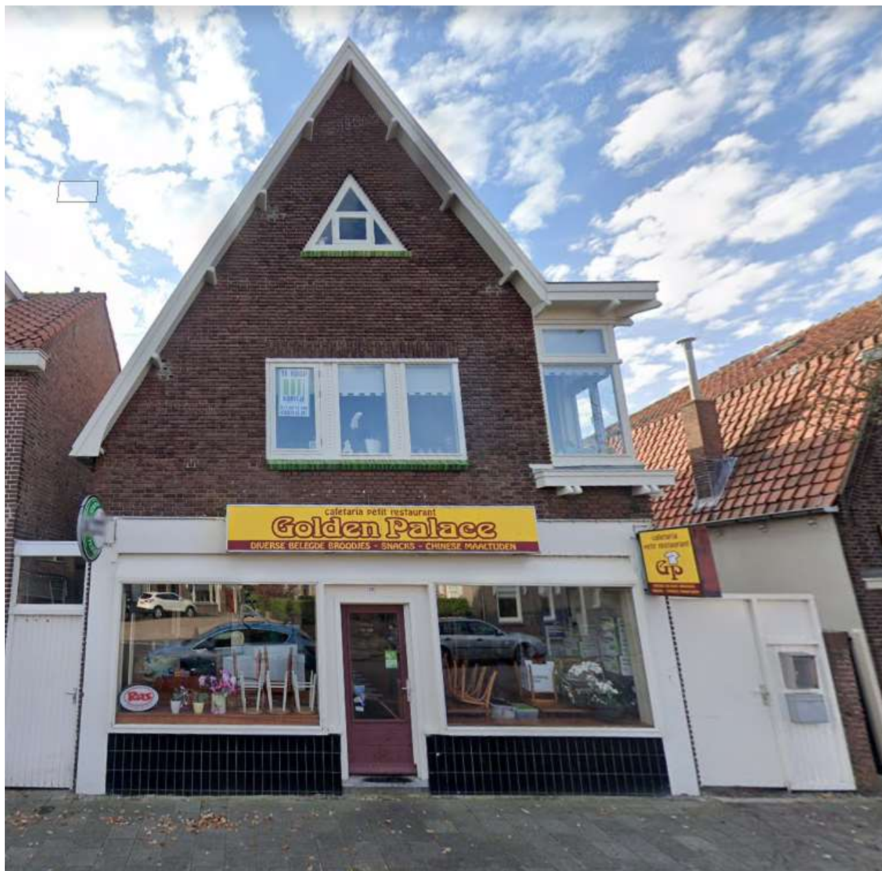
Figuur 1: Bestaande situatie voorgevel
