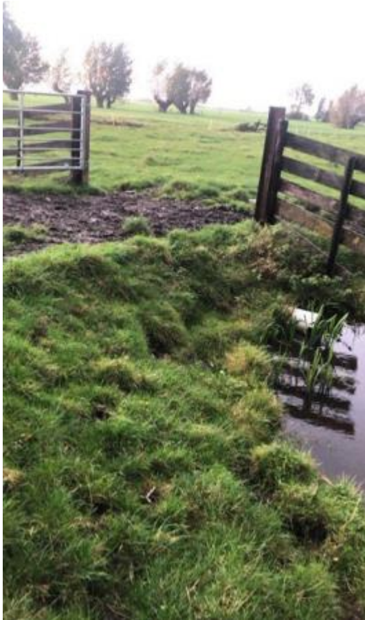
Aanleg van een dam met duiker op de locatie nabij Rietveld 38 in Woerden (HDSR81554)
